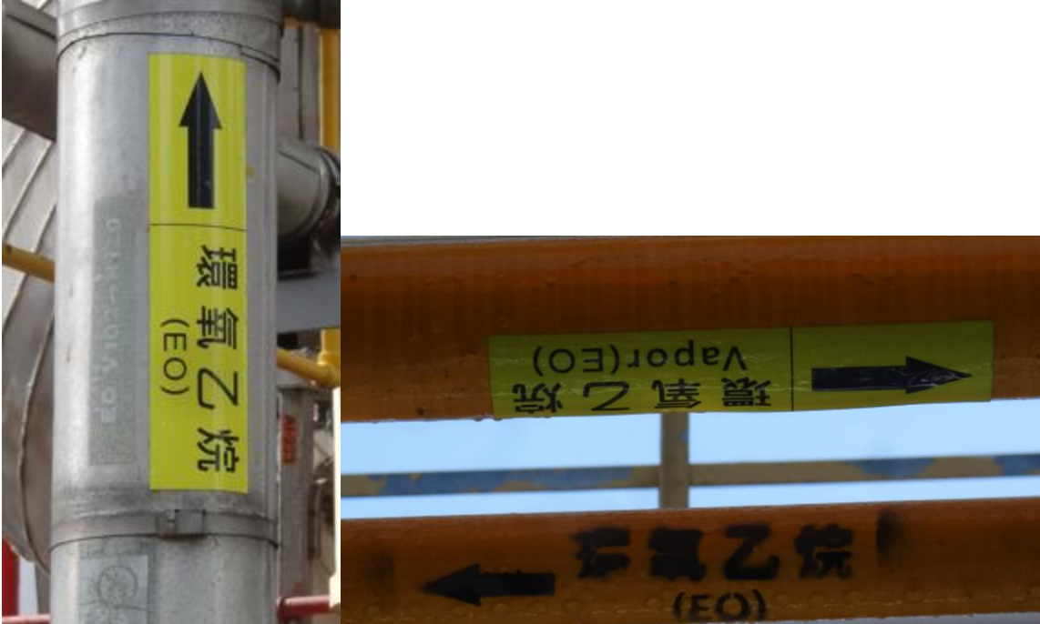
圖 3-3、環氧乙烷之運作導管、配管流向標示
